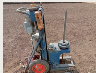
■ A点調査開始状況
